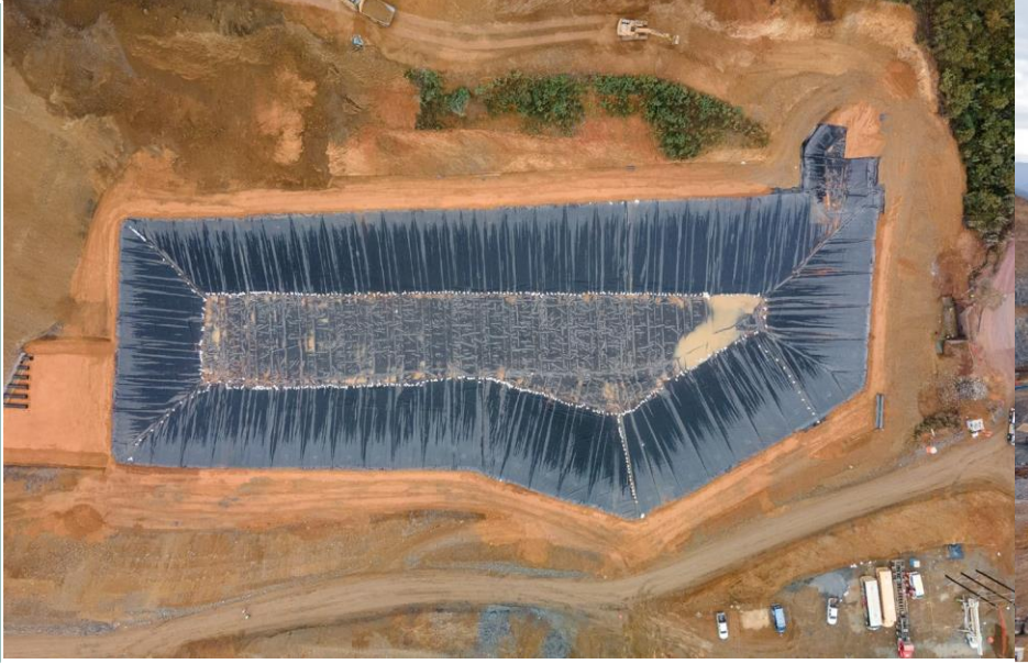
Instalación de revestimiento del estanque de contingencias.
