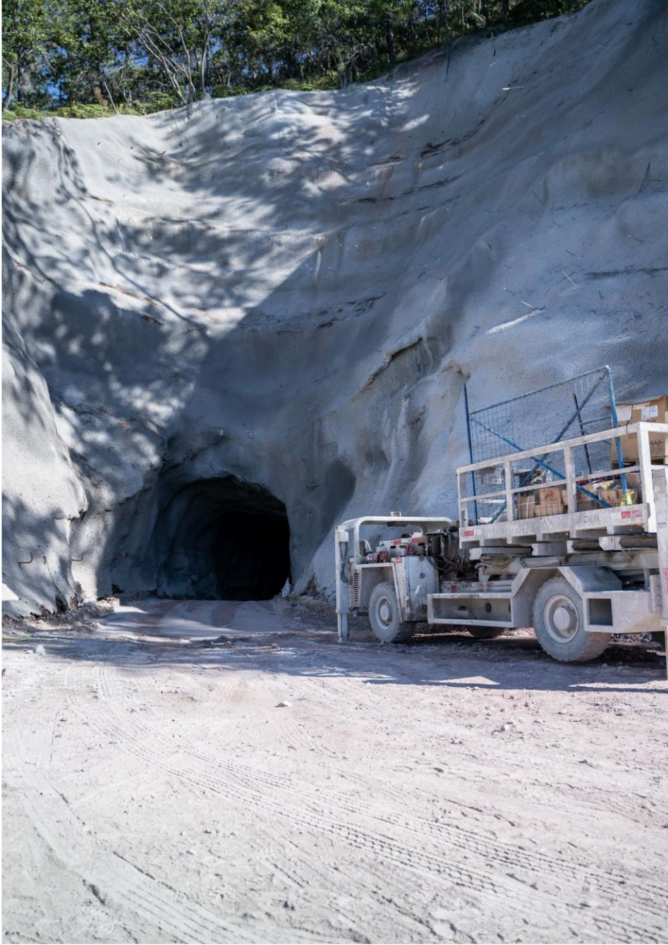
Acceso en el portal 4
