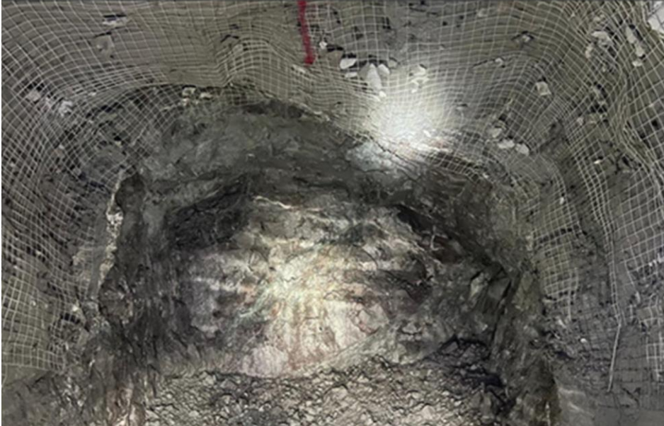
Desarrollo en el área de la rampa 2/4.
