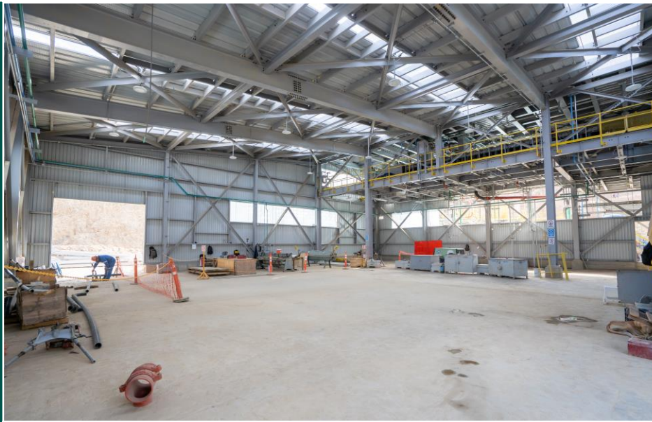
Edificio de almacenamiento de concentrado
