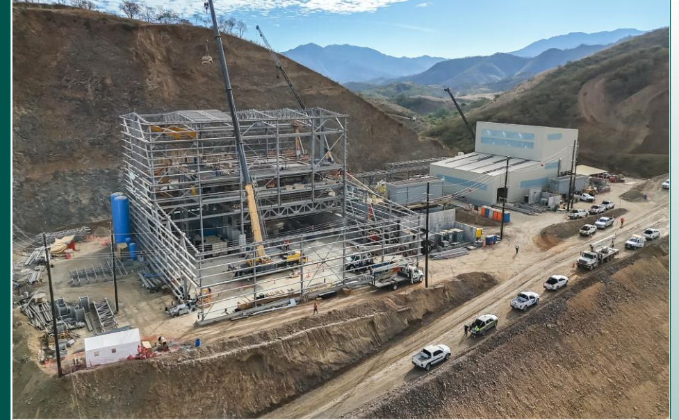
Avance del edificio del filtro de jales
