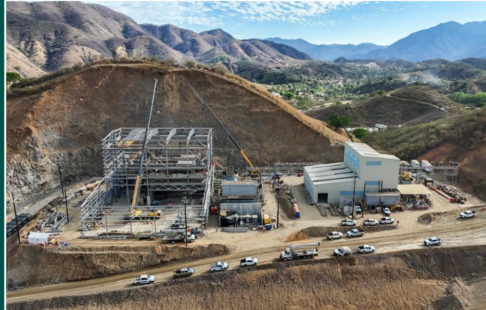
Edificios del filtro de jales y concentrado
