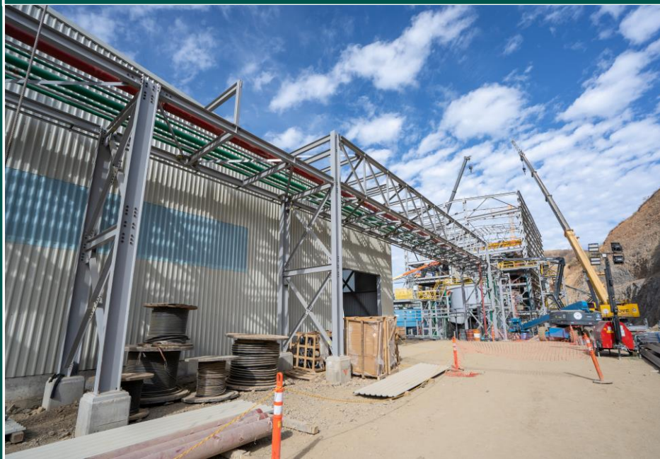
Bastidor de tuberías de la plataforma inferior
