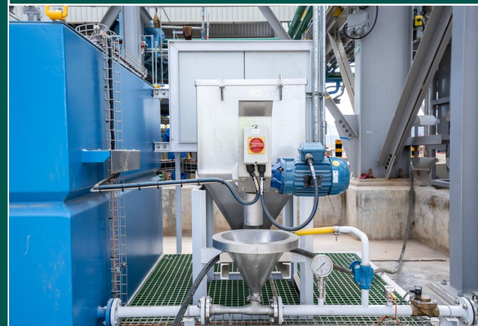
Instalaciones de equipos completas
