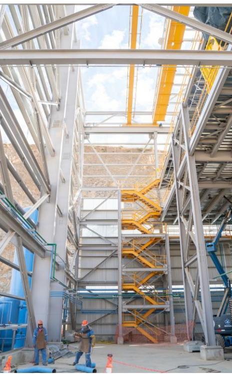
Bastidor de tuberías de la plataforma inferior
